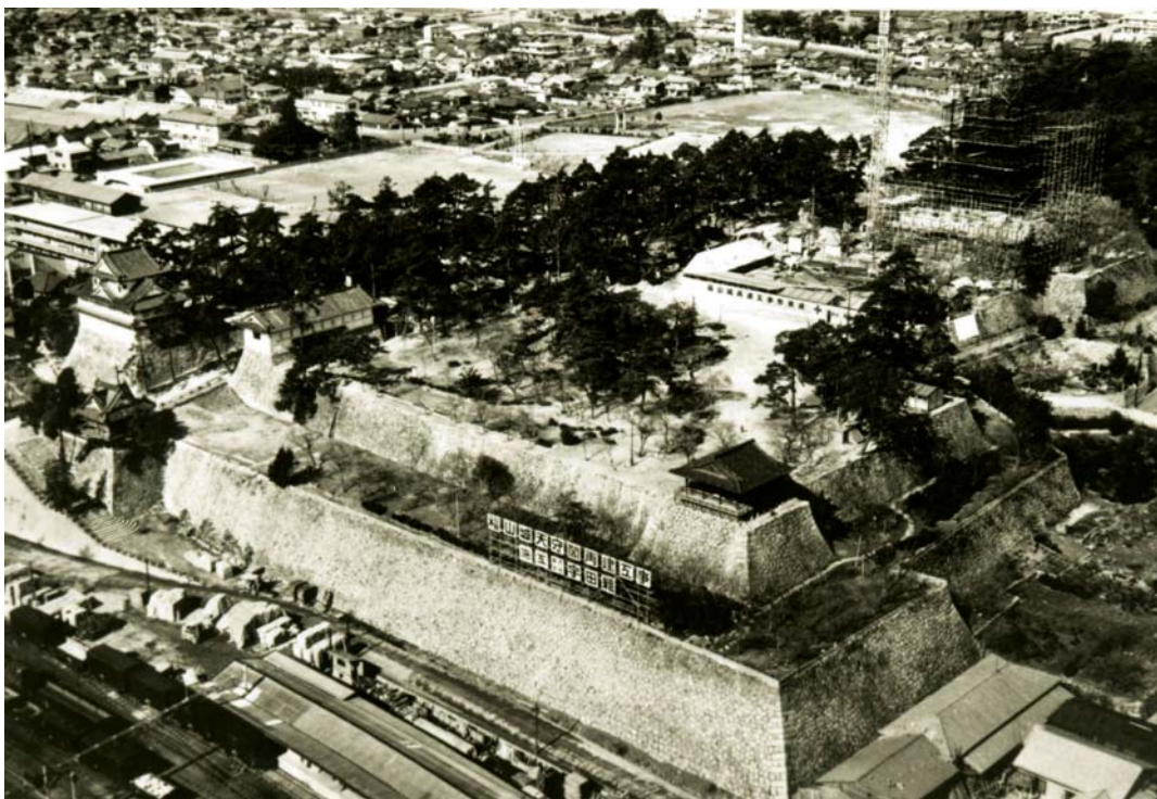
天守閣再建工事中の航空写真
